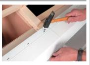
После соединения 2-х секций капельника закрепить их на месте гвоздями с крупными головками на равном расстоянии макс. 50 см.
