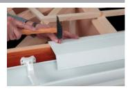
После соединения 2-х секций капельника закрепить их на месте гвоздями с крупными головками на равном расстоянии макс. 50 см. Капельник крепится к торцевой кровельной рейке. Использовать гвозди с крупной головкой для крепления капельника через овальные отверстия. Расстояние между гвоздями должно быть одинаковым и составлять макс. 50 см. Капельник необходимо установить в профиль хотя бы на 15 мм, в зависимости от модели водосточного желоба.
